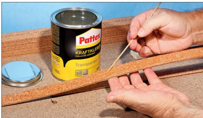
Die Unterseite der Korkstreifen wird mit Pattex-Kraftkleber bestrichen. Der bleibt elastisch und unterstützt die Schalldämmung.
