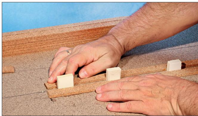
Mit auf die Gleismittelachse gestellten Distanzklötzchen konnten die H0-Korkstreifen für die breitere 0e-Bettung aufgeklebt werden.
