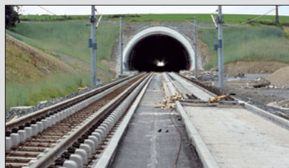
Hier ist der Übergang vom System Rheda mit Betontrug (vorne) zu Rheda 2000 ohne Trog im Hintergrund zu erkennen.
