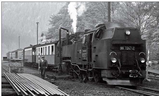
Ab 1978 baute man die Loks auf Druckluftbremse um. In der Anfangszeit behielt man die Saugluftbremse zusätzlich bei. Die Luftschläuche der Druckluftbremse lagen tiefer. *Fotos (2): Frank Pilz, Slg. Koch*
