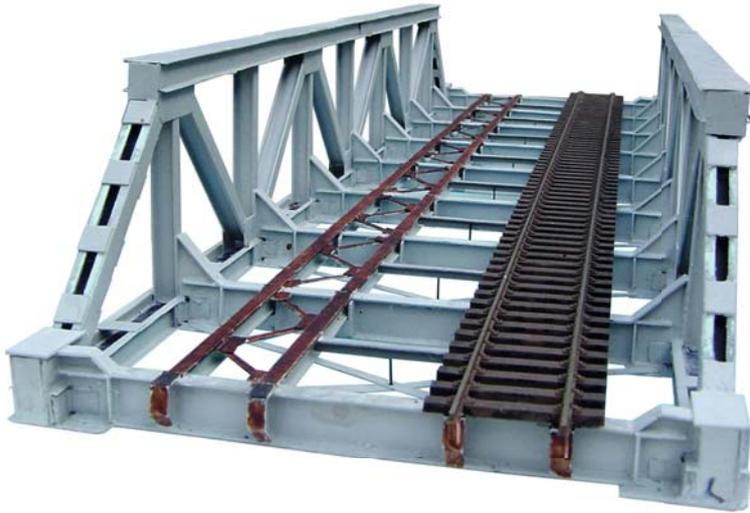
Ein selbst gebautes Modell der real existierenden Eisenbahnbrücke bei Stade zeigt alle statisch und konstruktiv notwendigen Bauteile außer den Auflagern. Das zweite Gleis fehlt, damit man den Brems- und Schlingerverband besser sieht.
