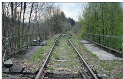
In der Ausfahrt von Hauzenberg befindet sich auf der Brücke eine Weiche, der Abzweig führt zum Schutzgleis. In einer Aussparung auf der Brücke finden Stellbock und Weichenlaterne Platz.
