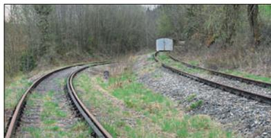
Das ansteigende Schutzgleis rechts soll das Abrollen von Wagen auf das Streckengleis verhindern. Die Rampe hinter dem Hausbahnsteig diente der Granitverladung.
