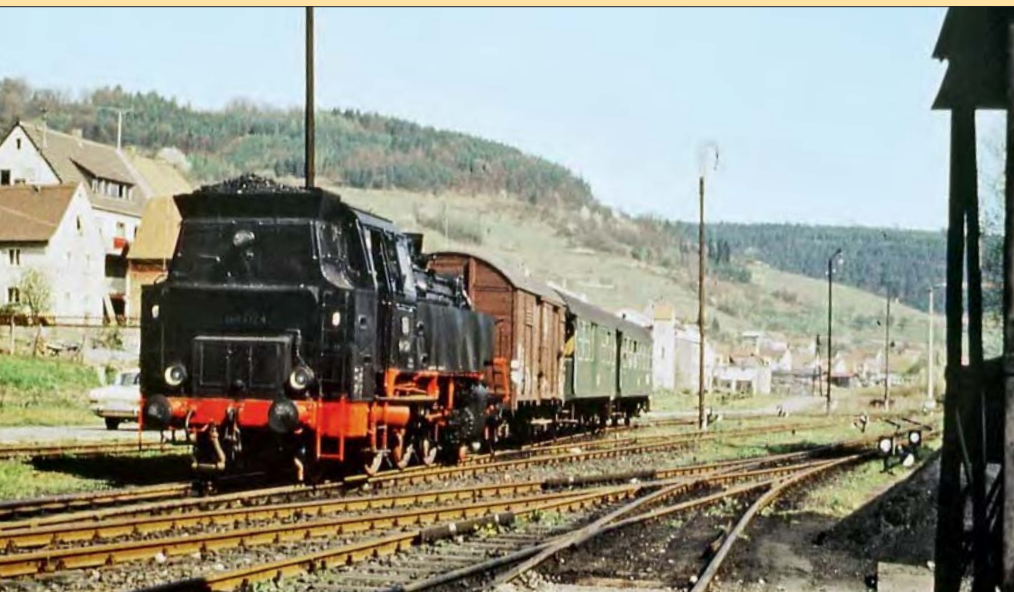
Die kleine Lokstation in Heimbuchenthal war mit einem Bekohlungskran ausgestattet. Seit Beginn der Fünfzigerjahre kamen auf der Strecke vor allem Loks der BR vom Bw Aschaffenburg zum Einsatz; eine typische Zuggarnitur dieser Zeit bestand aus einem Güterwagen und zwei dreiachsigen Umbauwagen. Fotos: Sammlung Höllerer
