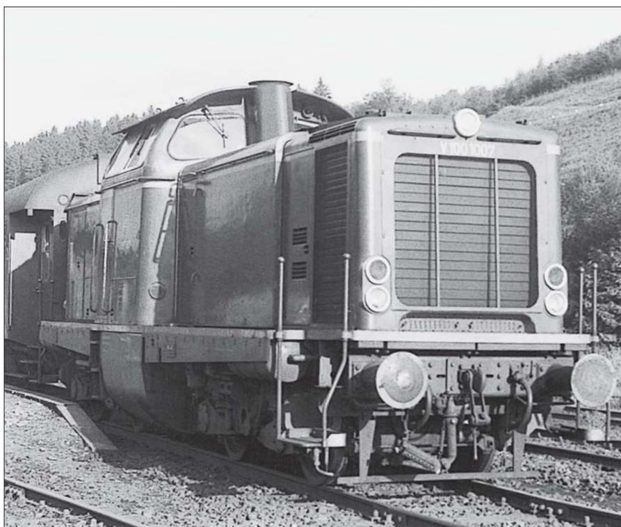
Rechts: Unterhalb des Führerhauses ist der zentrale Tank untergebracht. Er ist relativ zum Führerhaus ein Stück nach vorn versetzt, sodass die Einfüllstutzen auf dem Umlauf angeordnet werden konnten. 213 341 wird in ihrem Heimat-Bw Gießen mit Treibstoff versorgt. Foto: Peter Große
