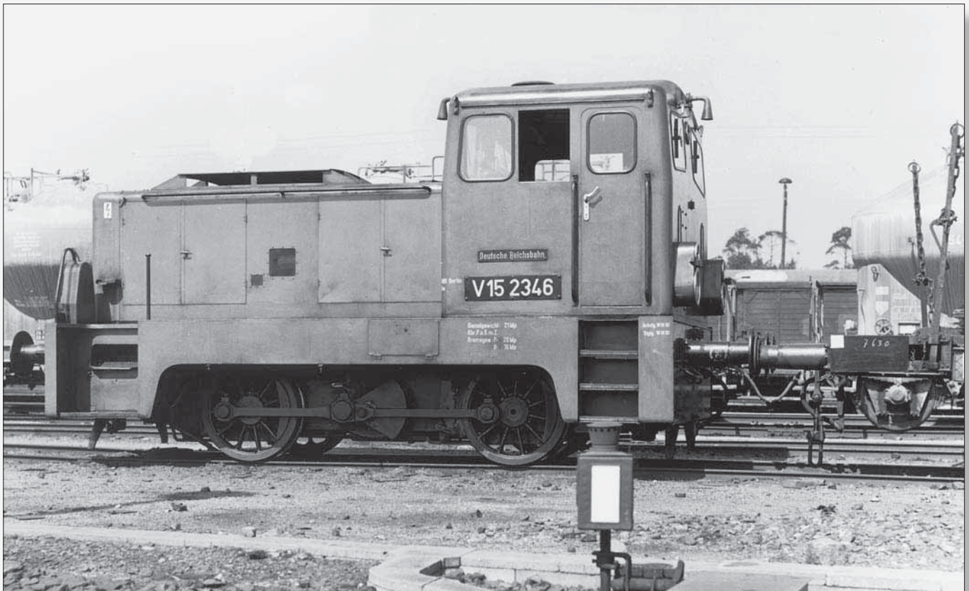
V 15 2346 des Bw Seddin von der linken Seite. Die für Einmannbedienung ausgelegten Lokomotiven überzeugten mit einer Reihe unübersehbarer Vorzüge, darunter dem geschlossenen, vergleichsweise geräumigen Führerhaus. Wer als Lokführer auf die V 15 gelangte, wollte auf keine T 3 mehr zurück – weder im Rangier- noch im Nebenbahndienst auf ehemaligen Kleinbahngleisen. Fotos: Archiv Dirk Endisch
