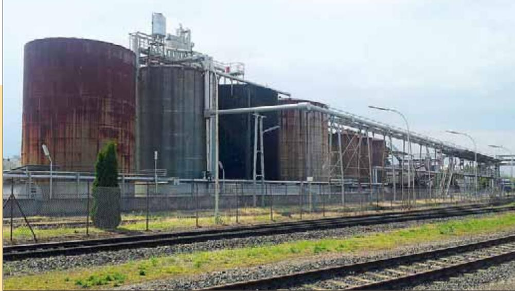
Im Hafen von Worms befindet sich eine Tankanlage, die als Vorbild für unsere Modellumsetzung diente. Die Tanks – in sehr unterschiedlichen Erhaltungszuständen – stehen hier ein Stück weit vom Hafenbecken entfernt, eine Leitungsbrücke stellt die Verbindung zu den Pumpstationen her.
